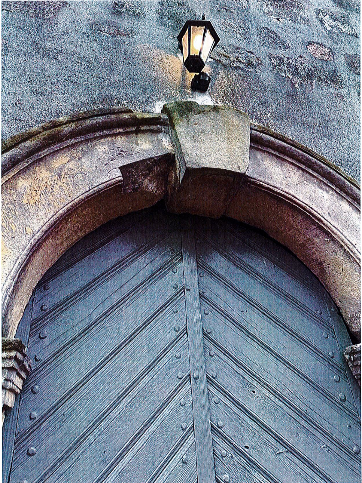
Portal główny - stan z lutego 2024 r. Zbliżenie na luk ze zwornikiem. Widoczny ubytki formy rzeźbiarskiej, zabrudzenia powierzchni, działalność mikroorganizmów, dezintegrację struktury kamienia. Autor fot. Katarzyna Pakuła
